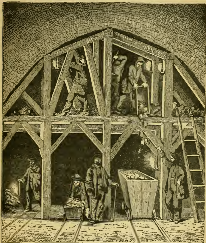
FIG. 97. — MAÇONNERIE DU TUNNEL.
